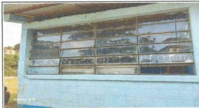
Foto 3 MÓDULO 4: PANORAMICA ESTADO DE VENTANAS
