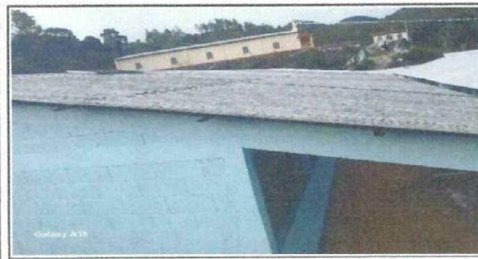
Foto 5 MÓDULO 2: LAMINAS CON DETERIORO.
